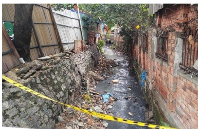
Les canaux d'évacuation des eaux pluviales de Tân Sơn Nhất doivent être nettoyés d'urgence.
